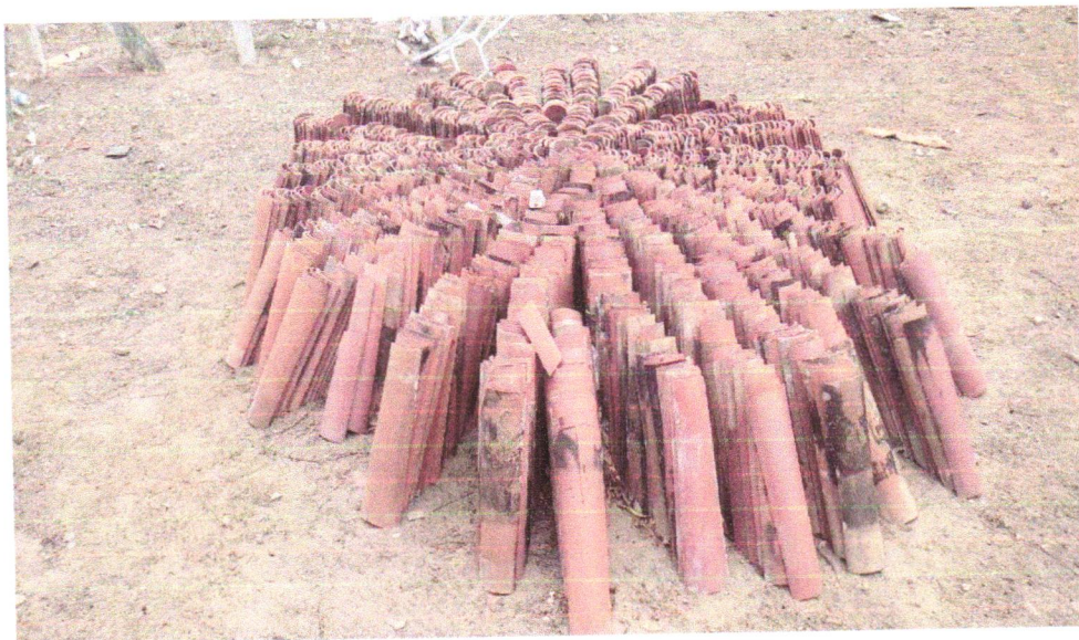
FOTO 09 – REMOÇÃO DE TELHAMENTO COM TELHAS CERÂMICAS
