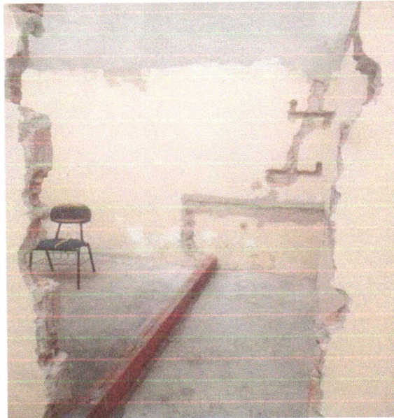
FOTO 05 – DEMOLIÇÃO DE REBOCO
