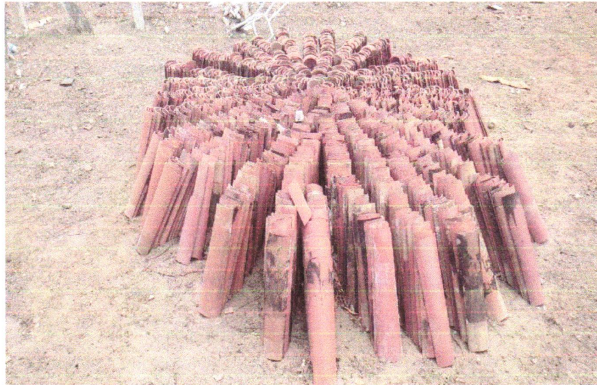
FOTO 04 - REMOÇÃO DE TELHAS, DE FIBROCIMENTO, METÁLICA E CERÂMICA, DE FORMA MANUAL, SEM REAPROVEITAMENTO. AF_12/2017
